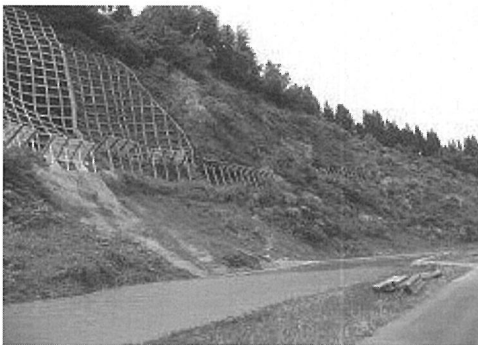
写真-3. 図-3中の防護施設の例(法枠工)
