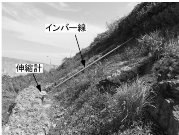
図-1. 伸縮計の設置状況
